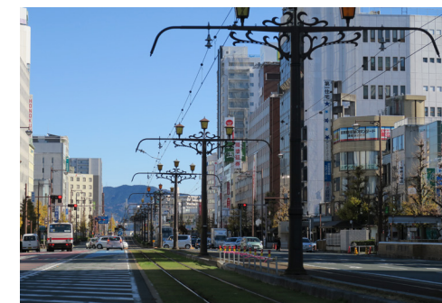
図15 センターポール化事業実施後の市内線の様子
