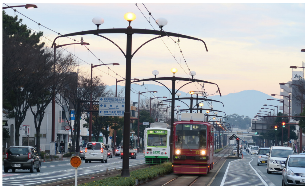
図14 センターポール化事業実施後の市内線の様子
