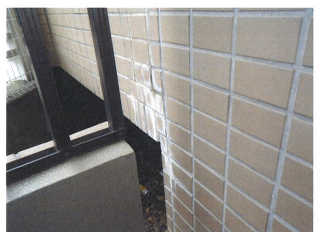
外部階段 外壁:エフロレッセンス
