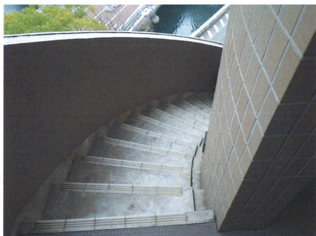
外部階段：全景
