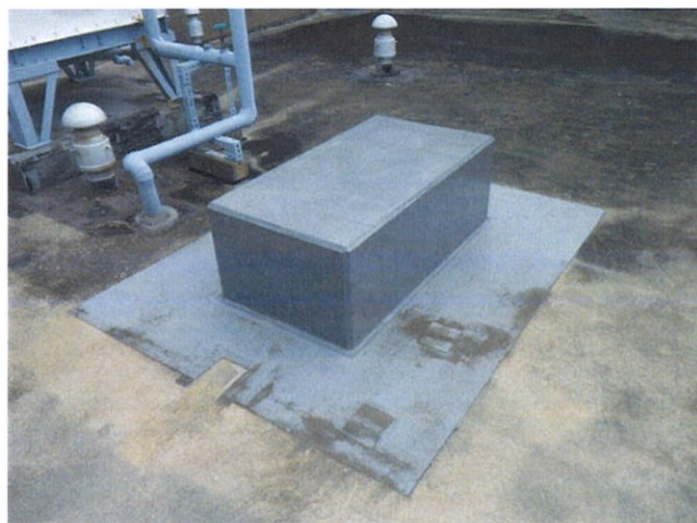
架台(ウレタン部)：保護塗料の退色
