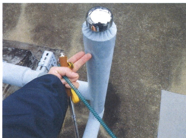
設備配管：チョーキング
