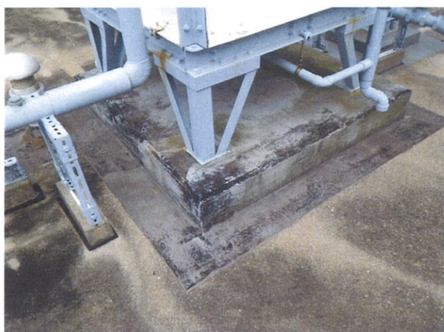
架台：保護塗料の退色
