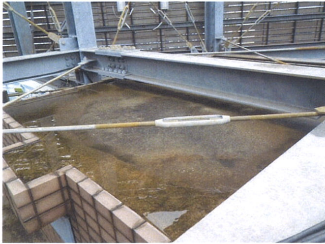
EVシャフト屋根:全景
