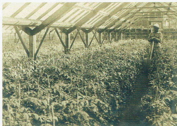
木造温室内部写真 昭和3年(1928) 個人蔵 儀兵も学んだとされる、豊橋の中島温室。渥美半島でも、初期の温室は木造フレームにガラスをはめて作られた。
