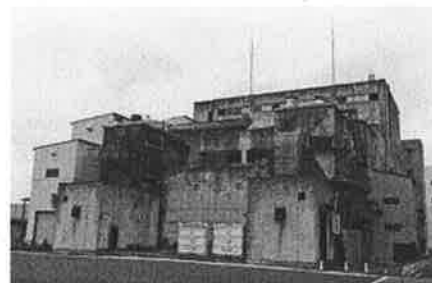
①旧ごみ焼却施設 場内の残置・残留物を先行して撤去した後、建屋の解体撤去工事を行います。
