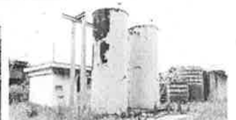
③沈殿処理水槽・取水電気室 ・沈砂池
