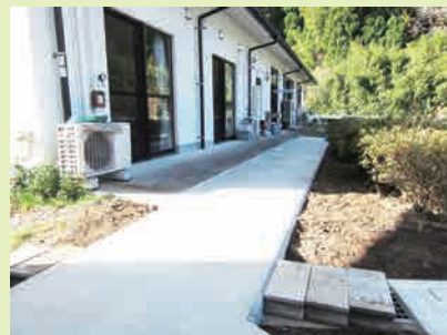
ユニット棟玄関から福寿苑へ向かう通路
