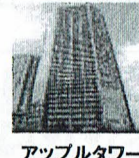
アップルタワー 東京キャナルコート
