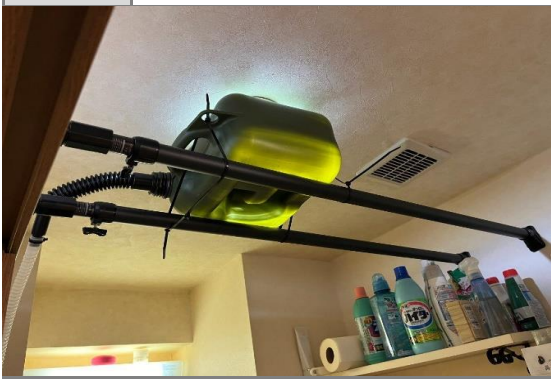
No.29 水受け養生
