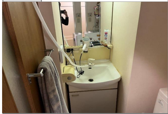
No.30 洗面化粧台シンクへ流れるよう養生
