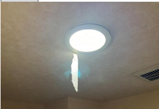
No.23 洗面脱衣所
