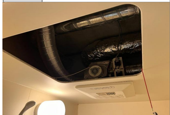
No.26 ユニットバス天井点検口から 洗面脱衣所天井裏の目視点検
