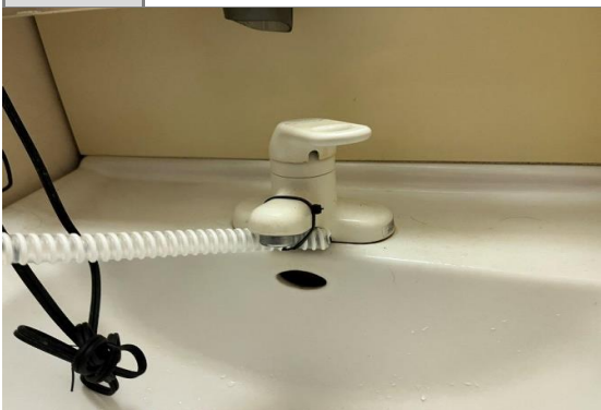
No.31 洗面化粧台シンクへ流れるよう養生
