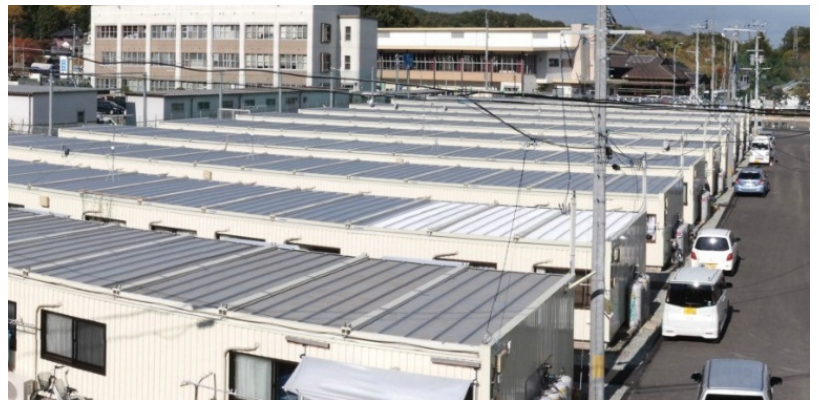
▲県内に建設された仮設住宅団地
