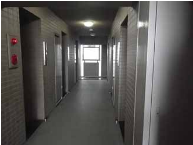
共用廊下:全景
