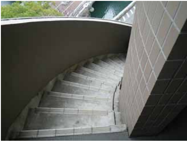
外部階段:全景
