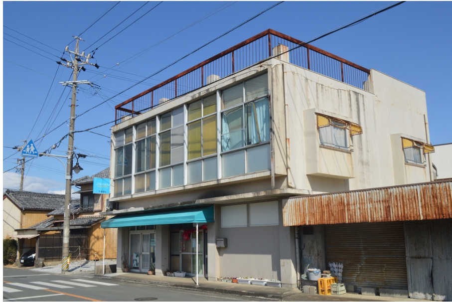
(写真) 江川の河岸東側にあるビル。
