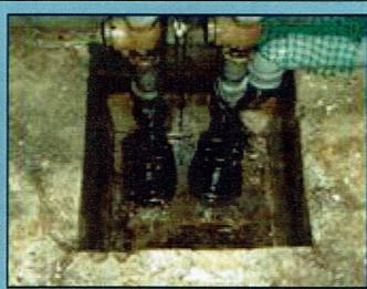
屋外に設置されている排水栓には雨水などが直接流入するため、枯葉や砂等の余計なゴミと一緒に流れ込んでいます。特に機械式駐車場においては、車からのオイルなども流れ込み他の場所に設置された排水ポンプに比べ、劣化が早くなるケースもございます。
